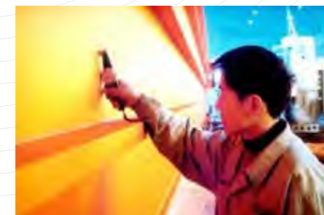
涂装检测 Coating Test
