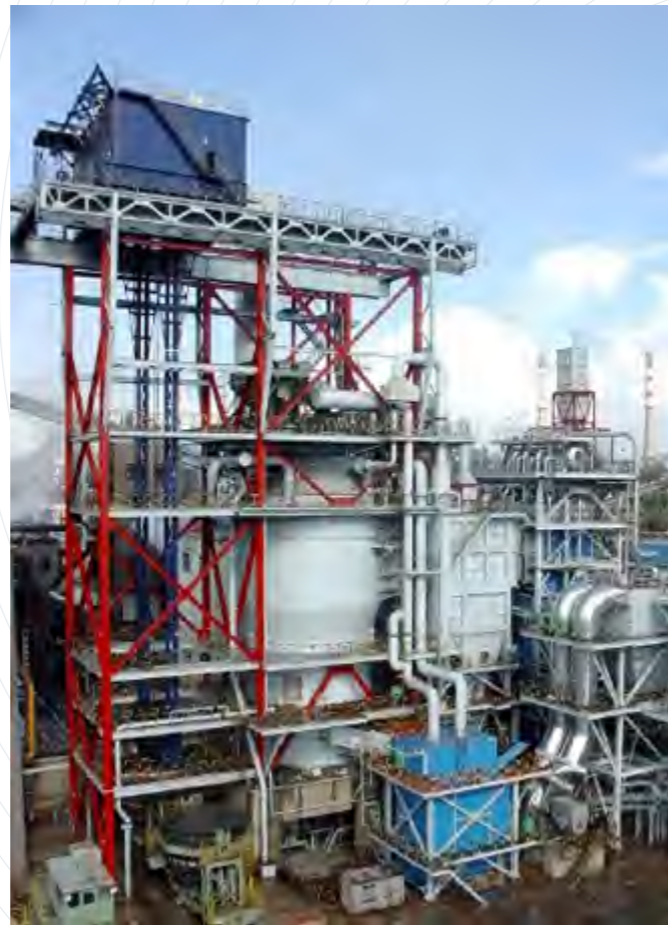
干熄焦提升机 Dry Quenching Lift
