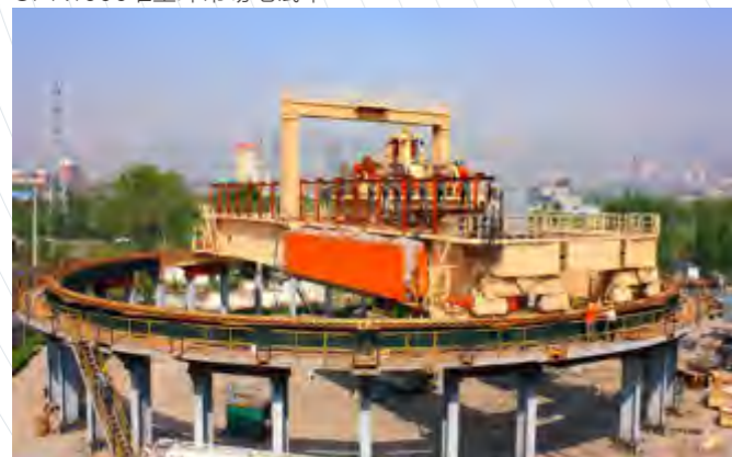
VVER堆型360吨环吊场地试车
